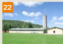
Fastighet: Kvarntorp 6:2 Gatuadress: Berghugnsvägen Bruksarea: 645 kvm Hyresgäst: Kumla kommun
