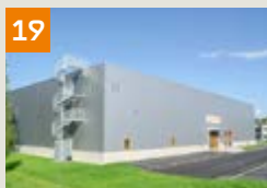
Fastighet: Kumla 12:91 Gatuadress: Mastgatan 1 Bruksarea: 2 604 kvm Hyresgäst: –
