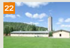
22 Fastighet: Kvarntorp 6:2 Gatuadress: Berghugnsvägen Bruksarea: 645 kvm Hyresgäst: Kumla kommun
