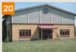
20 Fastighet: Kvarntorp 1:12 Gatuadress: Ljungströmsväg 13 Bruksarea: 775 kvm Hyresgäst: Kumla kommun
