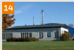
14 Fastighet: Hällabrottet 1:105 Gatuadress: Ramsåggsgatan 2 Bruksarea: 2 310 kvm Hyresgäst: Ellege Emballage
