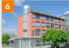
6 Fastighet: Borgmästaren 10, ofri grund Gatuadress: Torget 1 Bruksarea: 2 632 kvm Hyresgäst: Kumla kommun
