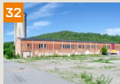
32 Fastighet: Kvarnatorp 6:13 Gatuadress: Berghugnsvägen Bruksarea: 1 800 kvm Hyresgäst: Svesten
