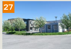
27 Fastighet: Kvarnatorp 6:5 Gatuadress: Berghugnsvägen Bruksarea: 3 263 kvm Hyresgäst: Epiroc
