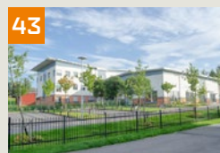
43 Fastighet: Transistorn 1 Borgen Gatuadress: Radiogatan 1–3 Bruksarea: Gemensam yta med Blå huset Hyresgäst: Kumla kommun
