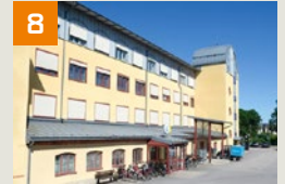
8 Fastighet: Fabrikören 4 Gatuadress: Magasinsgatan 4 Bruksarea: 3 895 kvm Hyresgäst: Colosseum, Smile, Kumla kommun, Länsgrädderi Fastigheter
