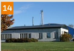
14 Fastighet: Hällabrottet 1:105 Gatuadress: Ramsåggsgatan 2 Bruksarea: 2 310 kvm Hyresgäst: Ellege Emballage
