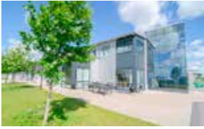
Fastighet: Axeln 7 Gatuadress: Vissbergagatan 12 Bruksarea: 9 342 kvm Hyresgäst: Swedish Lorry Parts
