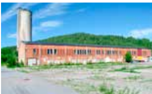
Fastighet: Kvarnatorp 6:13 Gatuadress: Berghugnsvägen Bruksarea: 1 800 kvm Hyresgäst: Svesten
