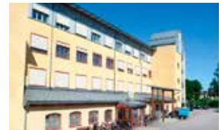
Fastighet: Fabrikören 4 Gatuadress: Magasinsgatan 4 Bruksarea: 3 895 kvm Hyresgäst: Colosseum, Smile, Kumla kommun, Länsgården fastigheter
