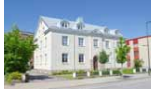
Fastighet: Svanen 14 Gatuadress: Stationsgatan 14 Bruksarea: 1 016 kvm Hyresgäst: Region Örebro Län, (Bostäder)
