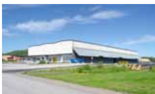
Fastighet: Kvarnorp 6:6 Gatuadress: Berghugnsvägen 2 Bruksarea: 6 988 kvm Hyresgäst: Pontus & Partner
