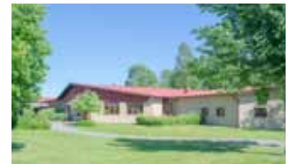
Fastighet: Ängen 1 Gatuadress: Korstagatan 5 Bruksarea: 1 396 kvm Hyresgäst: Kumla kommun
