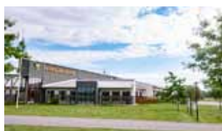
Fastighet: Byrsta 3:20 Gatuadress: Byrsta Bruksarea: 2 774 kvm Hyresgäst: Nerikes Brandkår, Region Örebro län
