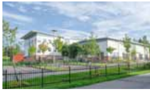
Fastighet: Transistorn 1 Borgen Gatuadress: Radiogatan 1-3 Bruksarea: Gemensam yta med Blå huset Hyresgäst: Kumla kommun
