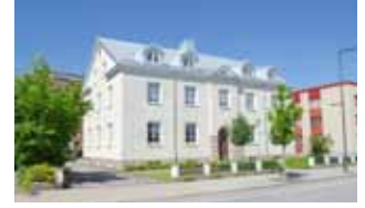
Fastighet: Svanen 14 Gatuadress: Stationsgatan 14 Bruksarea: 1 016 kvm Hyresgäst: Region Örebro Län, (Bostäder)
