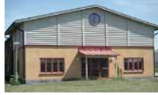
Fastighet: Kvarntorp 1:12 Gatuadress: Ljungströmsväg 13 Bruksarea: 774 kvm Hyresgäst: Kumla kommun
