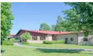
Fastighet: Ängen 1 Gatuadress: Korstagatan 5 Bruksarea: 1 396 kvm Hyresgäst: Kumla kommun
