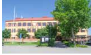
Fastighet: Skomakaren 5 Gatuadress: S Kungsvägen 1 Bruksarea: 4 630 kvm Hyresgäst: AME, Kumla kommun, 3 G Infrastructure
