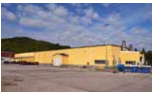
Fastighet: Kvarntorp 6:11 Gatuadress: Linbanevägen Bruksarea: 3 311 kvm Hyresgäst: Epiroc
