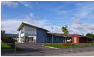
Fastighet: Transistorn 1 Gatuadress: Radiogatan 1-3 Bruksarea: 4 227 kvm Hyresgäst: Kumla kommun
