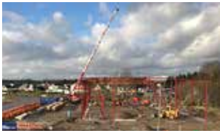
Fastighet: Kumla 12:91 Gatuadress: Mastgatan 1 Pågående byggnation
