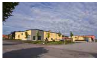
Fastighet: Kvarntorp 6:4 Gatuadress: Berghugnsvägen, Krossvägen Bruksarea: 10 730 kvm Hyresgäst: Millcon, Epiroc, JRP paper trading, Wokk Storkök AB m.fl.
