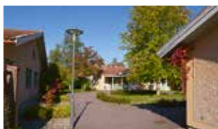
Fastighet: Hällabrottet 1:101 Gatuadress: Kapellgatan 6 Bruksarea: 456 kvm Hyresgäst: Kumla kommun m.fl.
