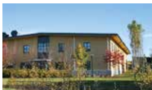
Fastighet: Axeln 6 Gatuadress: Viagatan 23 Bruksarea: 1 611 kvm Hyresgäst: Plåtteknik i Kumla
