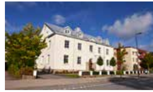
Fastighet: Svanen 14 Gatuadress: Stationsgatan 14 Bruksarea: 840 kvm Hyresgäst: Region Örebro Län, lägenheter
