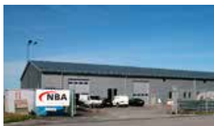
Fastighet: Blåmesen 4 Gatuadress: Ymergatan 4 Bruksarea: 1 440 kvm Hyresgäst: Kumla Kommun, Kumla Bostäder, PO:a akustikmontage, Abolins Bygg
